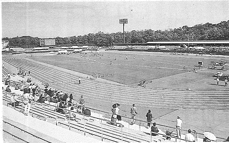
来年4月の日本パラ陸上を控え、トラック舗装を張り替える陸上競技場(鳥取市布勢)
